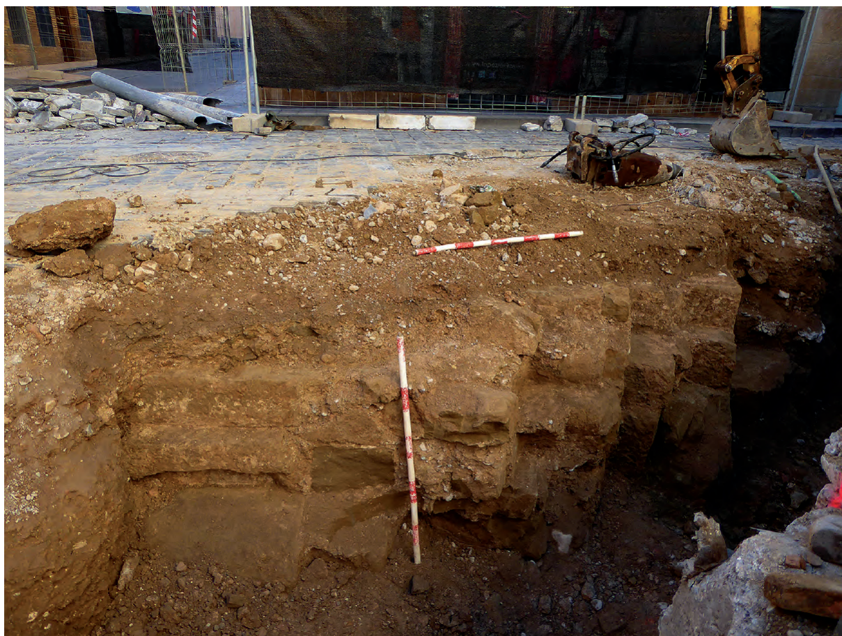
Estructura localizada en el perfil oeste de la zanja (AB). Arriba a la izquierda se aprecia el entronque entre las calles Cuatro Reyes y Ramiro el Monje.
