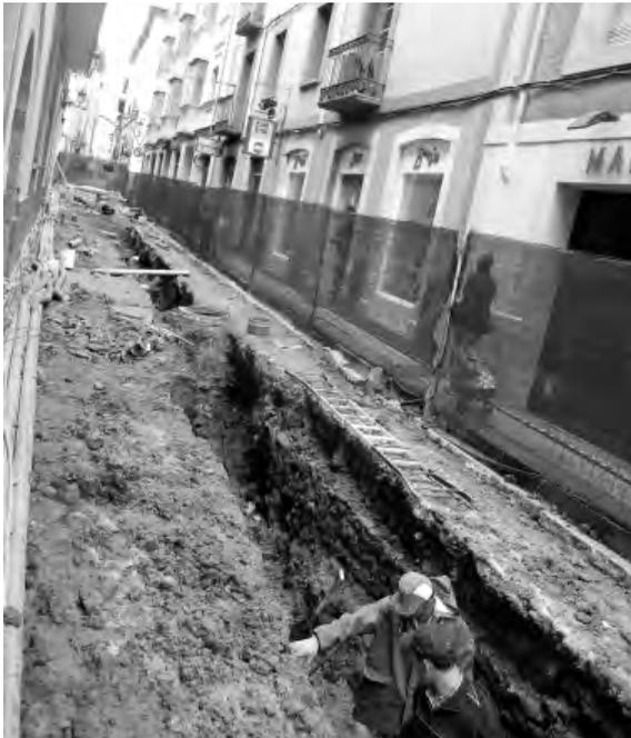
*Fig. 58.* Calle Ramón y Cajal. Zanja abierta para la renovación de la red de saneamiento,
