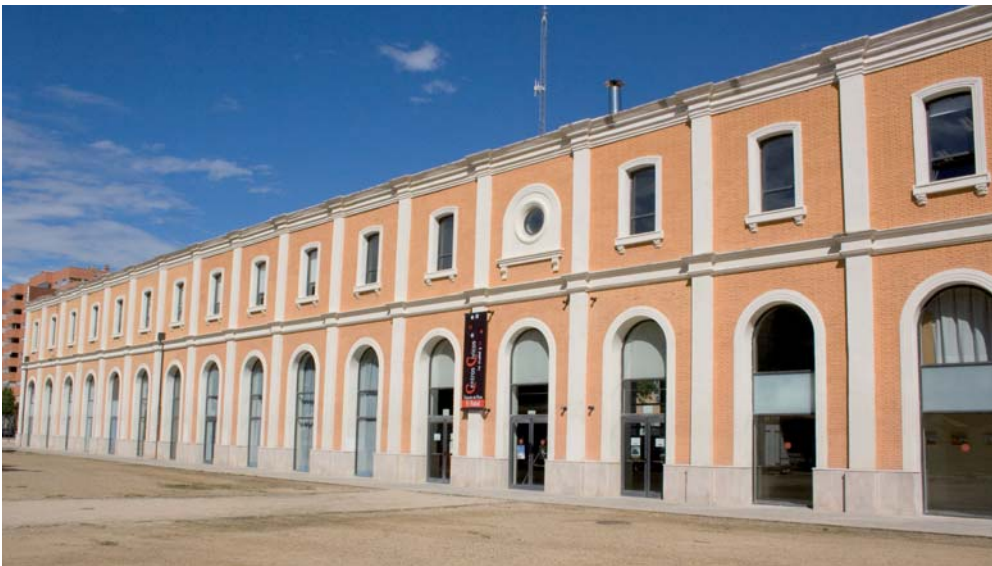
Estación del Norte de Zaragoza, hoy centro cívico: alzado principal del edificio de entrada y fachada correspondiente al lado de las vías desaparecidas. (Fotos: Carlos Colás)
