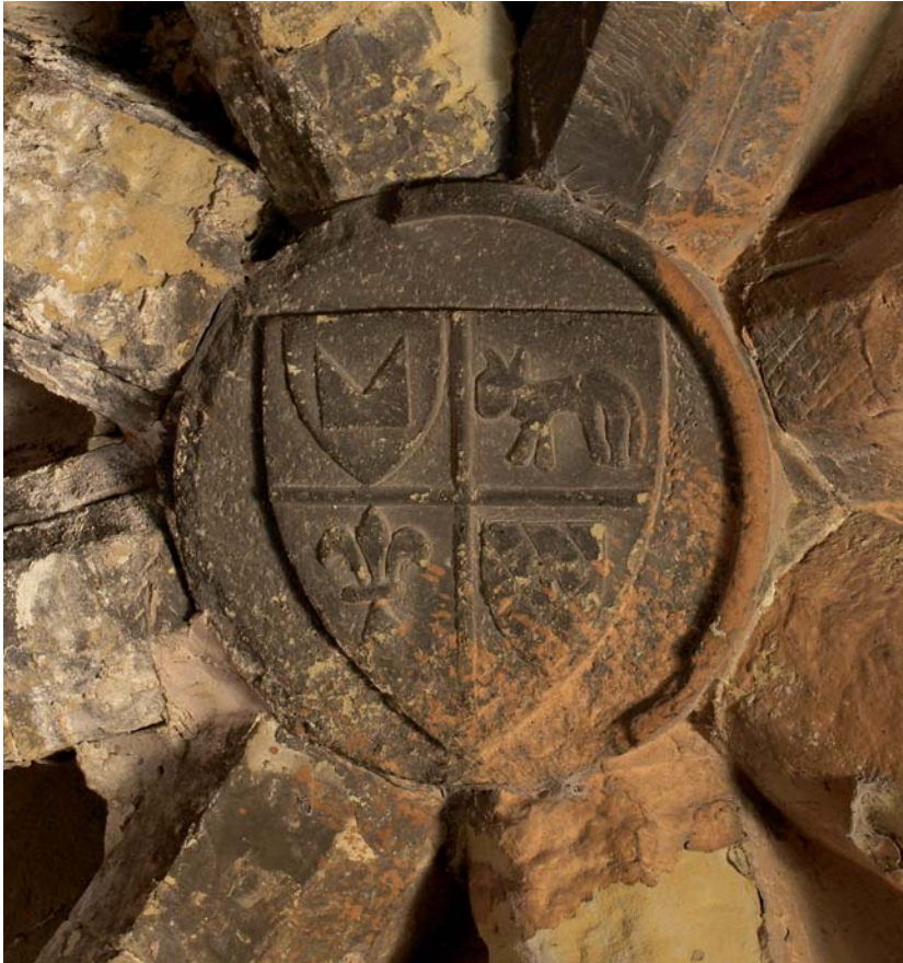
Escudo, todavía sin estudiar, que figura en la bóveda de una de las plantas de la gran torre de la catedral. Su identificación podría aclarar el proceso constructivo de la torre. (Foto: Antonio García Omedes)
