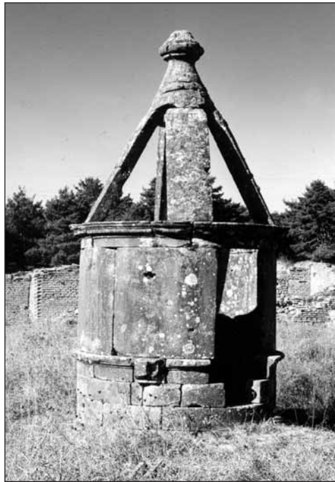
Aljibe del monasterio de San Juan de la Peña ubicado en el centro del claustro, donde se almacenaba agua para el consumo de los monjes de la comunidad.
