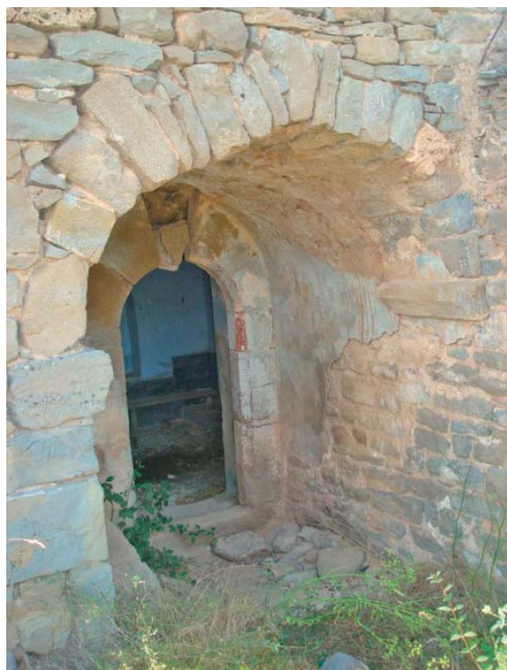
Figura 13. Arco adovelado que marca la entrada.
