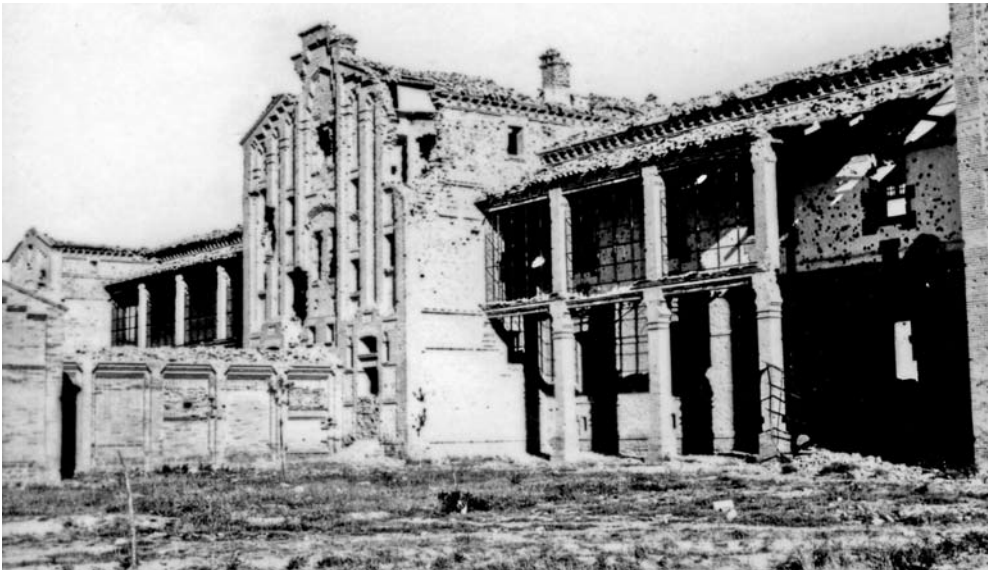
Aspecto de la parte central del pabellón de alienados después de finalizar la guerra. El cuerpo central distribuía simétricamente los espacios de las dos alas. En primer término, las dependencias femeninas. (Foto: Diego Quiroga. Fototeca de la Diputación de Huesca)
