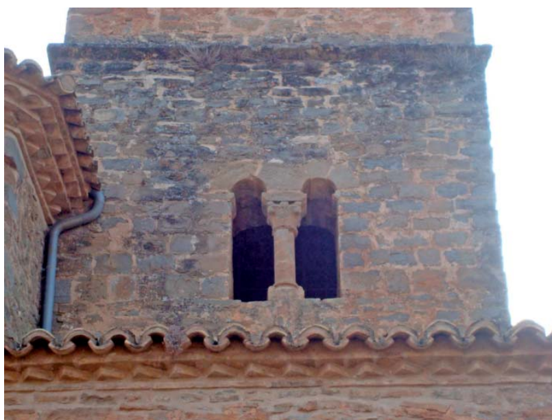
Figura 7. Vanos del lado este de la torre de la iglesia de San Juan de Rodellar.
