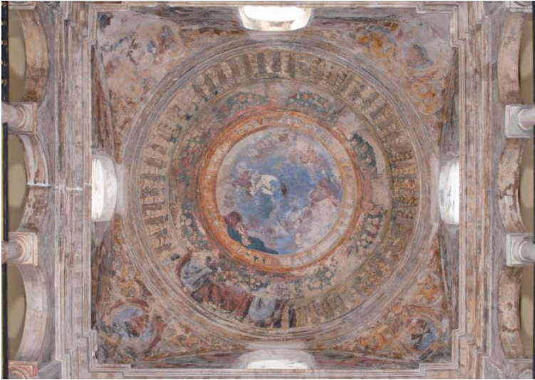
Cúpula de la capilla de los santos Justo y Pastor. (Foto: Antique Restauración de Arte)
