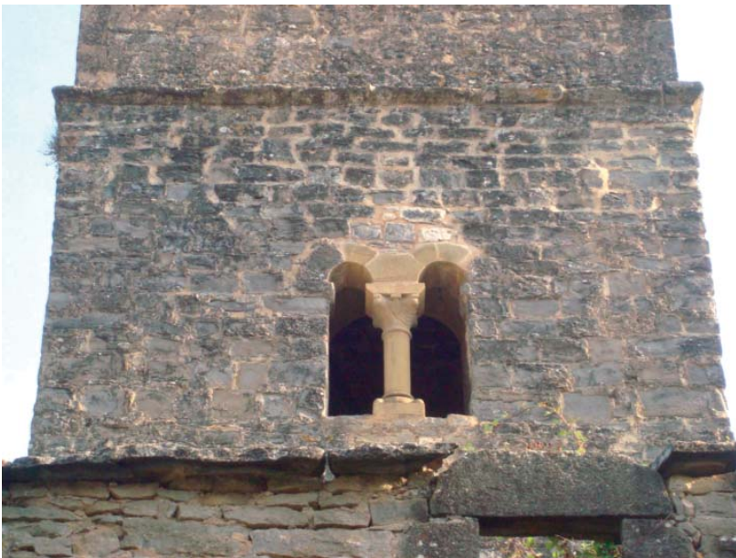
Figura 5. Vanos del lado norte de la torre de la iglesia de San Juan de Rodellar.
