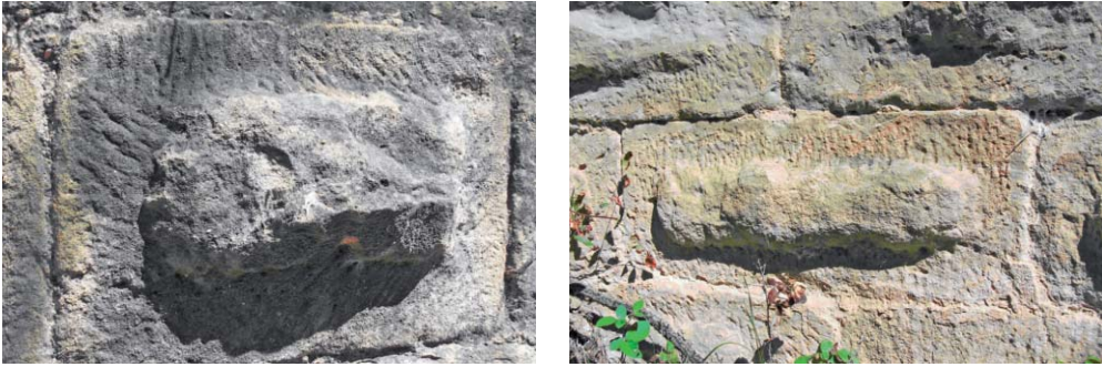
Figuras 7 y 8. Sillares almohadillados en la cara exterior del estribo de la orilla derecha.
