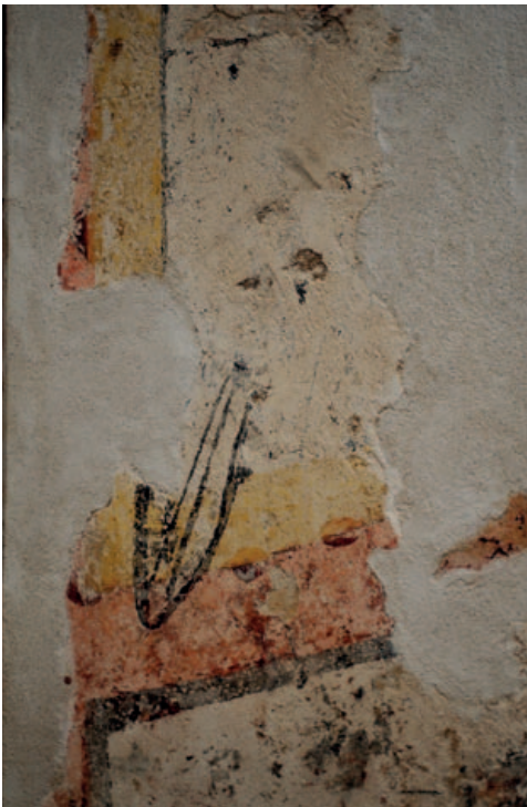
Impronta del caballero de la parte izquierda de la ventana en su estado actual in situ. (Foto: Pablo Otín, octubre de 2023)
