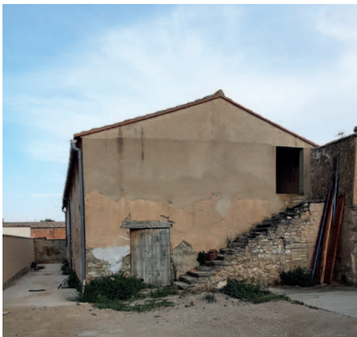
Casa Teodoro. (Foto: Carlos Escanilla Quirós)
