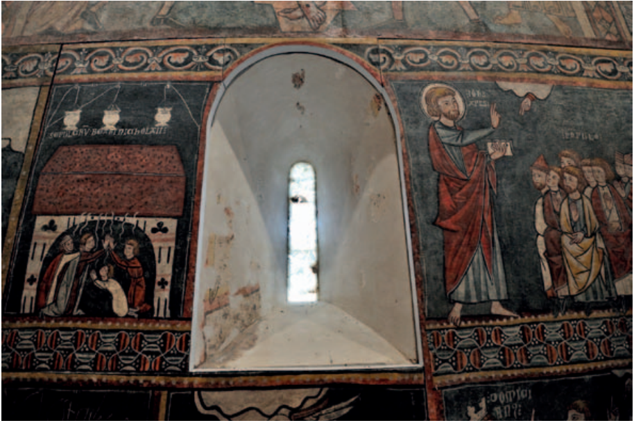
Sector central del testero en su estado actual. (Foto: Pablo Otín, octubre de 2023)
