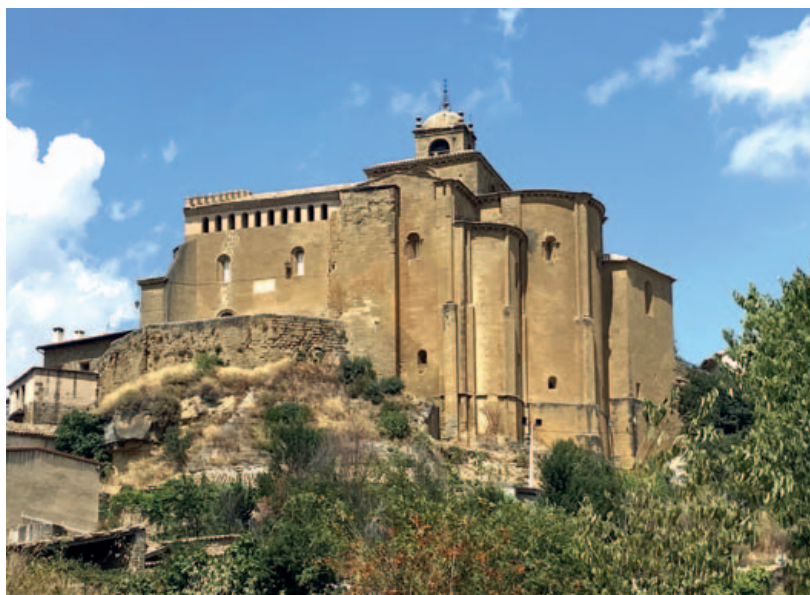
Vista exterior de la iglesia de San Salvador de Murillo de Gállego, destacado edificio románico de los siglos XI-XII. (Foto: Javier Martínez Molina)
