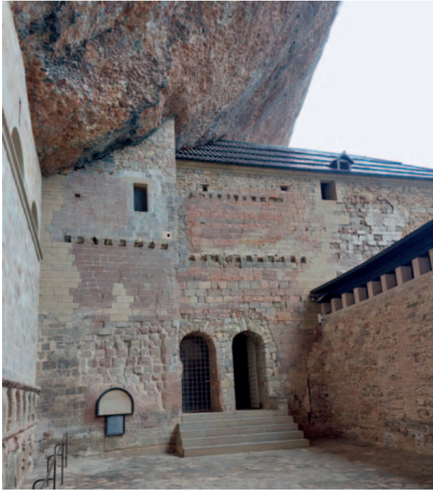
Actual entrada de la iglesia desde el panteón de nobles, con doble vano en arco. (Foto: José Luis Solano Rozas)
