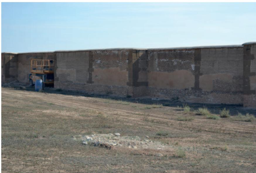
*Muro de cierre perimetral, en el que pueden apreciarse estratificados los diferentes tapias que lo componen.*
