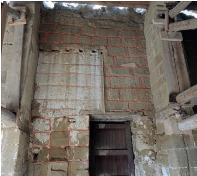
Figura 24. Lienzo situado junto a la cata 7 (muro B en figura 15). Se observa un interesante sistema constructivo, más próximo a obras andaluzas que a paramentos propios del estilo románico.
