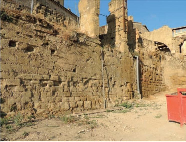
*Figura 28. Lienzo exterior (A en figura 15), interesante paramento que manifiesta diferentes momentos constructivos y que en su día constituiría el muro exterior de las dependencias de los canónigos.*
