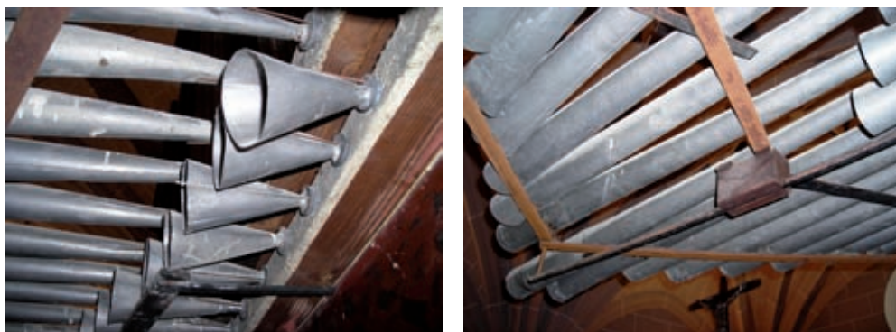
A la izquierda, detalle de los clarines. A la derecha, vista de los tubos de bajoncillo en pirámide.
