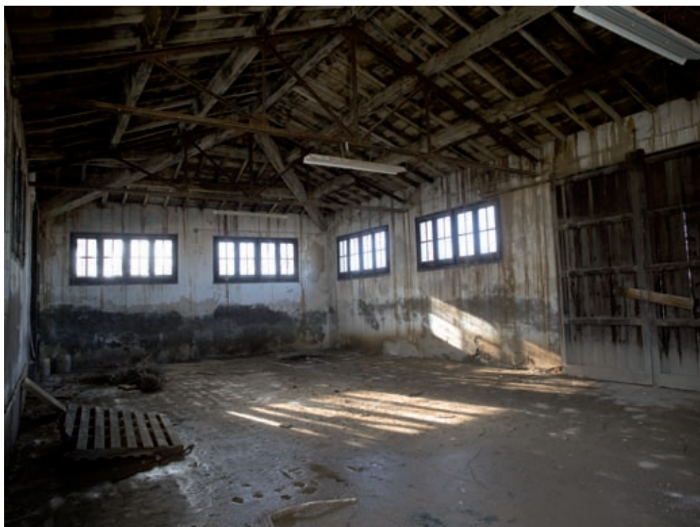
Cerchas de la cubierta de la nave. (Foto: Javier de la Fuente Cobos)
