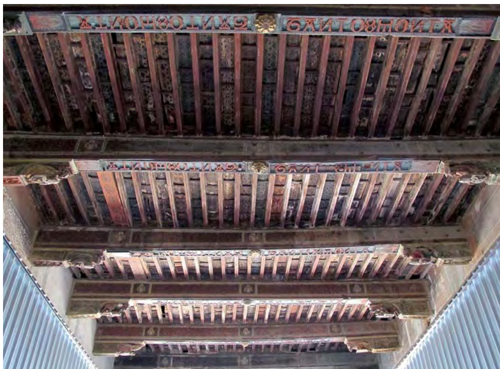
El alfarje del Tanto Monta en 2012, antes de la restauración. (Foto: M.ª Celia Fontana Calvo)
