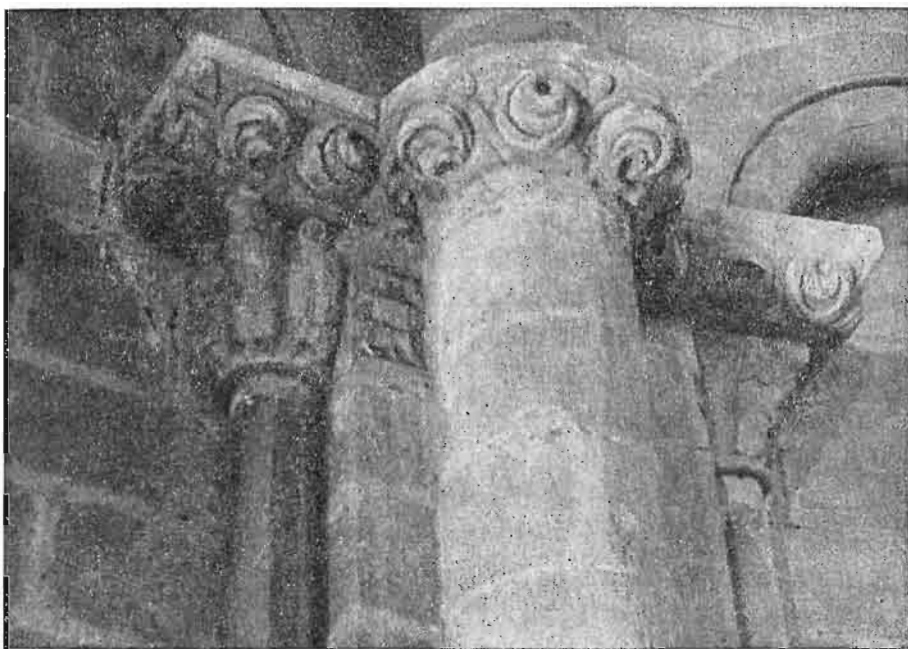
Fotografía 2.—Detalle de columnas y capiteles.
