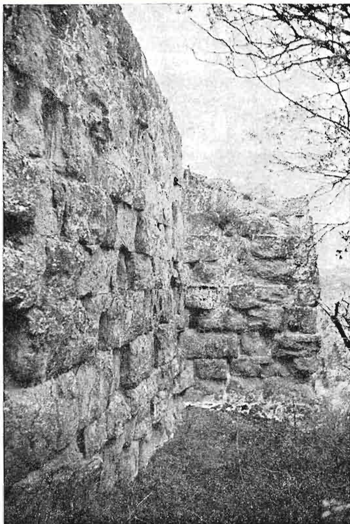
Detalle del muro del castillo de Sant Joan
