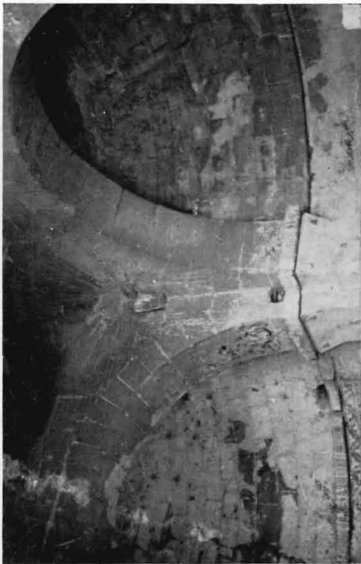
7. — Detalle de los arcos que dan acceso a los ábsides centro y sur, trompa y canecillo
