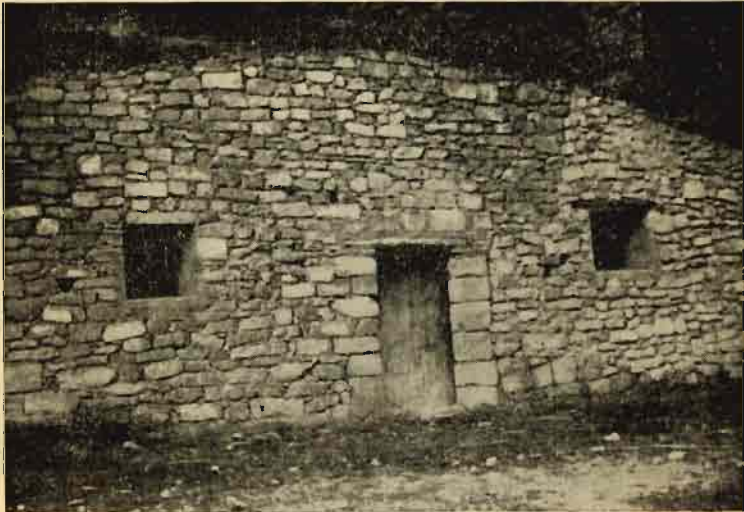
Muro de piedra, de sillares irregulares
