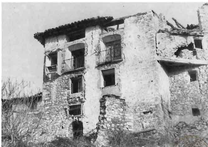
Puy de Cinca. Vista parcial.
