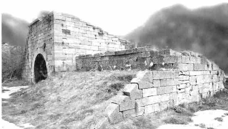
Frente oriental. Con su casamata, terraplén de circulación, talud, terraplén de combate y parapeto. Nótese el revestimiento lateral de los últimos y la formación de la batería artillera del SE (a la derecha)
