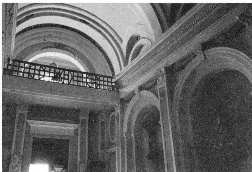
Figura 6. Interior de la nave y coro.
