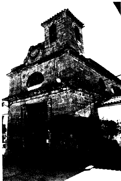
Figura 2. Vista general del exterior desde la plaza.
