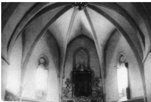
El ábside antes de la intervención.
