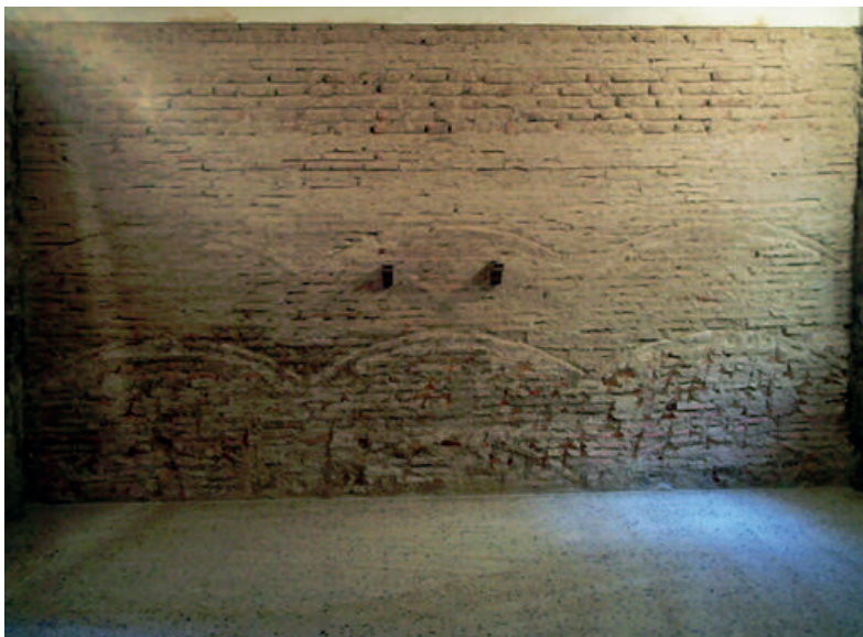
La sala capitular en obras. Al fondo, la pared que linda con el antiguo carnerario. 2010.
