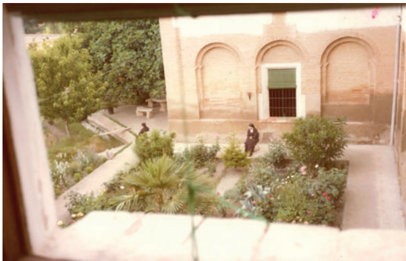
Fachada que da a la huerta, con los arcos cerrados, antes de 1986, cuando todavía no se había instalado la fuente de la Virgen del Carmen.
