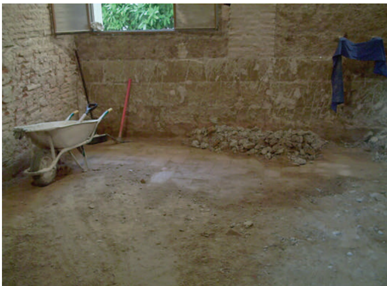
La sala capitular en obras con el hallazgo del suelo original. 2010.
