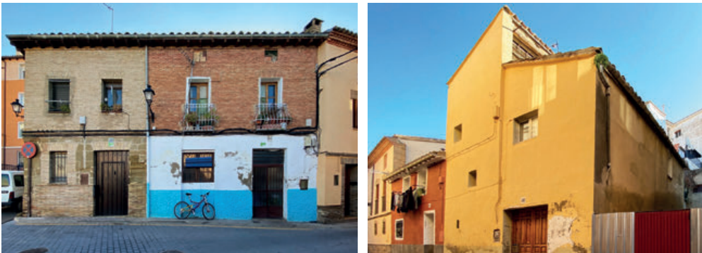
Las imágenes en conjunto, de derecha a izquierda, muestran el callejón Pedro IV (cerrado con puerta de uralita) y los números 58-66 de la calle Pedro IV, inmuebles construidos en el solar del antiguo colegio de Santa Orosia. (Fotos: M. a Celia Fontana Calvo)
