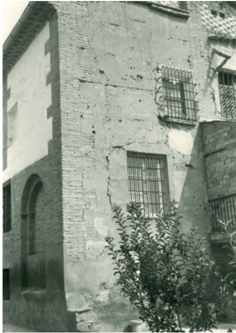
Fachada del ala lateral sur, con la terraza de la sala de labor tabicada en la parte derecha de la imagen, antes de 1993.
