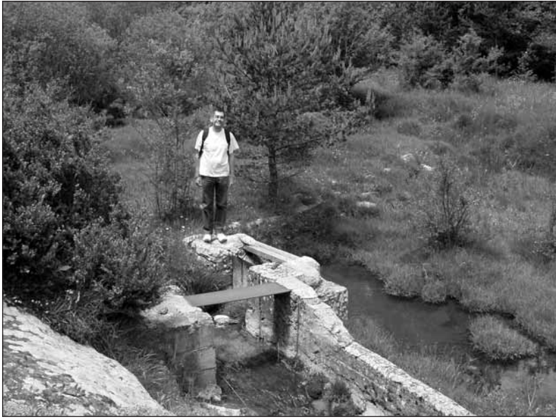
Figura 3. Azud e inicio de la actual acequia de Bonés. Junio de 2007.
