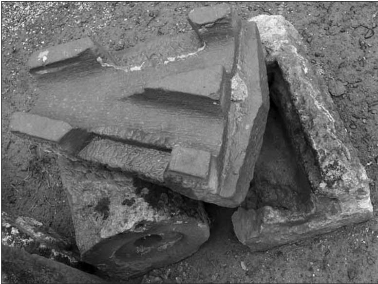
Restos de las conducciones del aljibe proyectado por Artiga para solucionar el problema de abastecimiento de agua en San Juan de la Peña.
