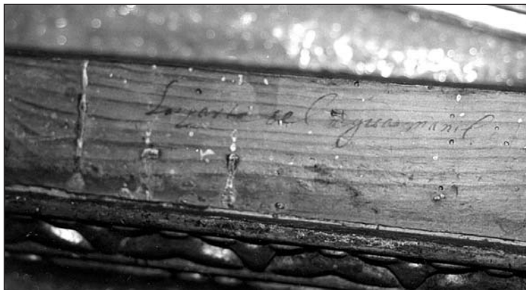
Mazonería de la sacristía de la iglesia de San Lorenzo. Inscripción realizada a tinta para señalar la ubicación de las piezas: La parte del aguamanil.
