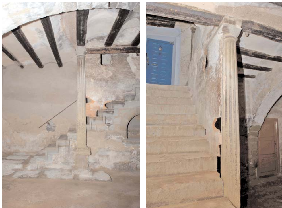
Figs. 4 y 5. Loscorrales (Huesca). Columna asentada en el zaguán de una casa. (Fotos cedidas por Carmen Gómez Urdáñez)
