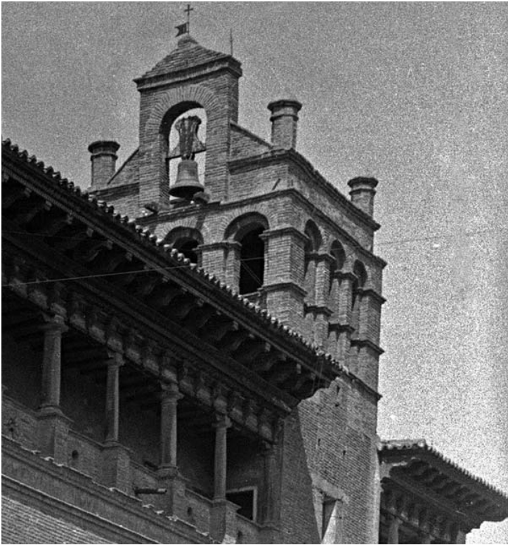
Detalle de una fotografía en la que se aprecia muy bien la campana en su espadaña de ladrillo, rematada por una veleta con una cruz. (Foto: Ricardo del Arco. Fototeca, Diputación de Huesca)
