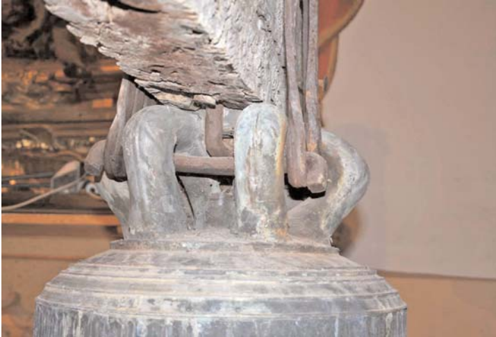
Piezas metálicas que unen la campana al yugo. (Foto: Ayuntamiento de Huesca)
