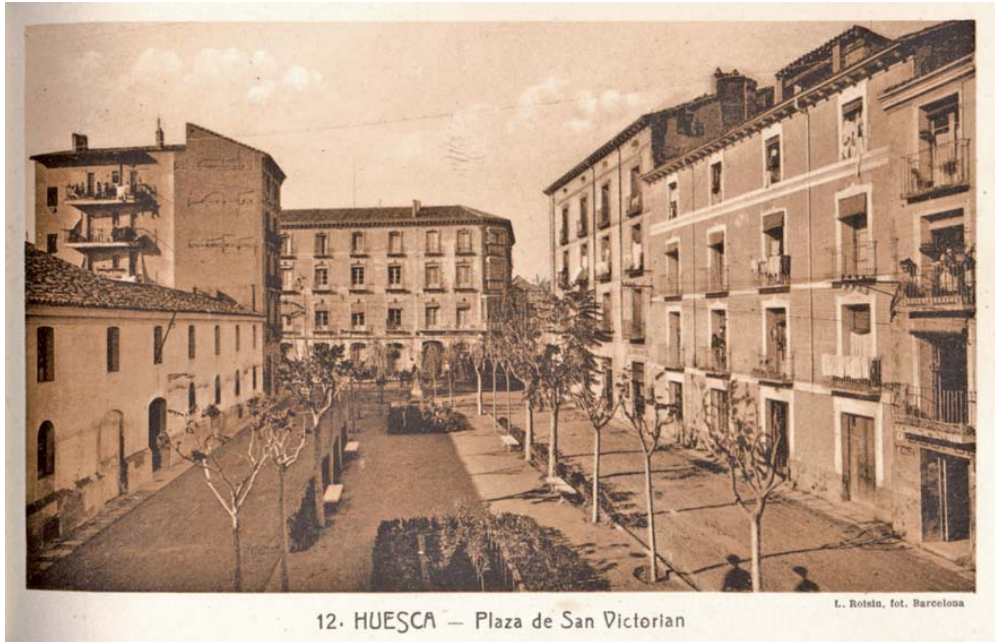
Plaza de San Victorian. A la izquierda, el edificio del antiguo colegio de carmelitas descalzas adaptado para cárcel. (Foto: L. Roisin. Fototeca de la Diputación de Huesca)
