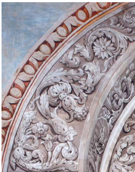
Grisallas que tratan de enmascarar el acceso descentrado a la capilla. (Foto: Fernando Alvira Lizano)
