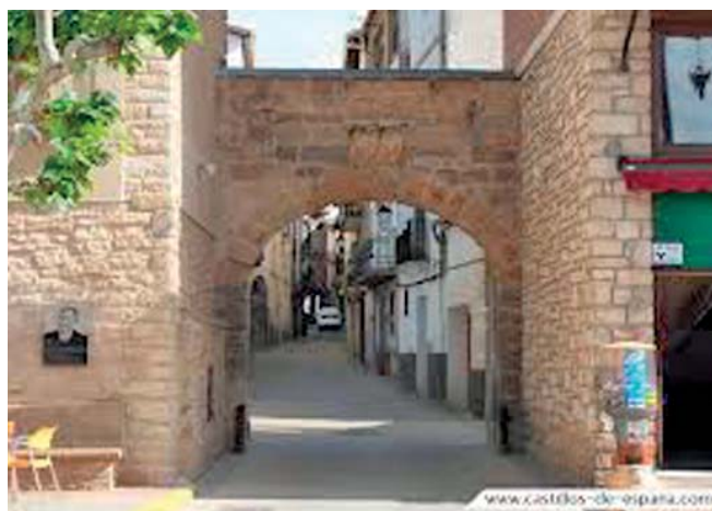
Arco medieval del portal del Sol.
