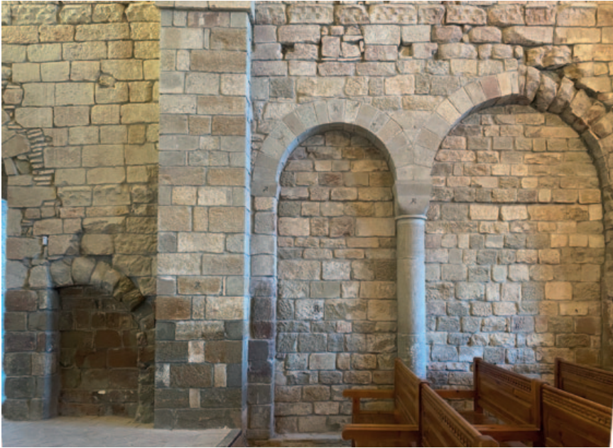
Impostas a dos niveles en el muro de poniente de la iglesia románica. Monasterio de San Juan de la Peña. (Foto: M. a Celia Fontana Calvo)
