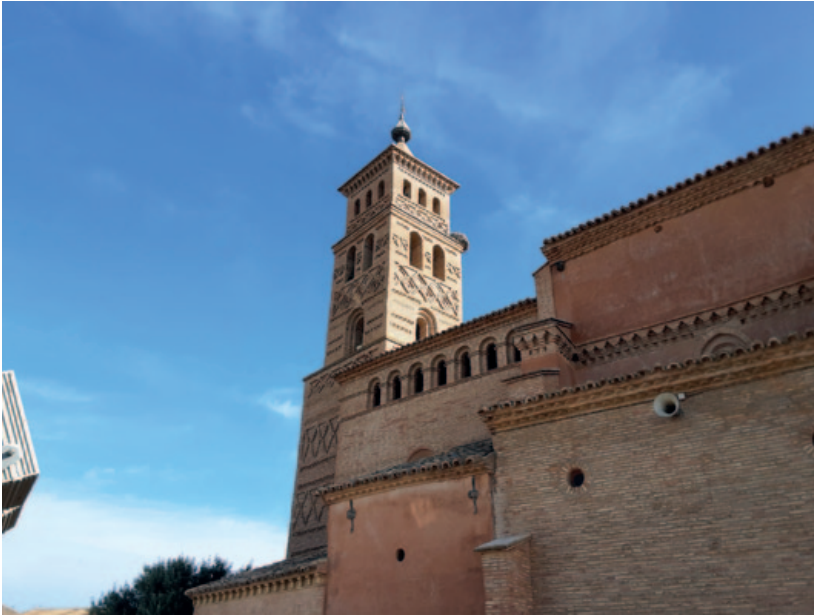
Iglesia de Santa Ana. (Foto: Carlos Escanilla Quirós)
