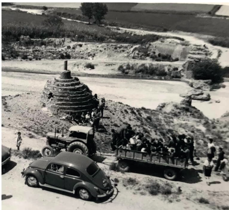
Las pilastras del antiguo puente del Alcanadre a mediados del siglo XX. (Fondo Salvador Trallero)
