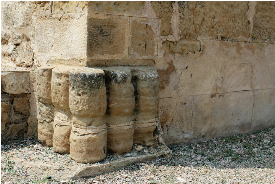
Arriba, restos de un antiguo basamento en la esquina izquierda de la fachada de la ermita. Abajo, detalle del basamento reaprovechado. (Fotos: Gemma Grau Gallardo)
