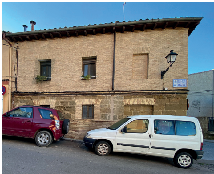
Fachada norte del número 66 de la calle Pedro IV, uno de los inmuebles construidos en el solar del antiguo colegio de Santa Orosia.
