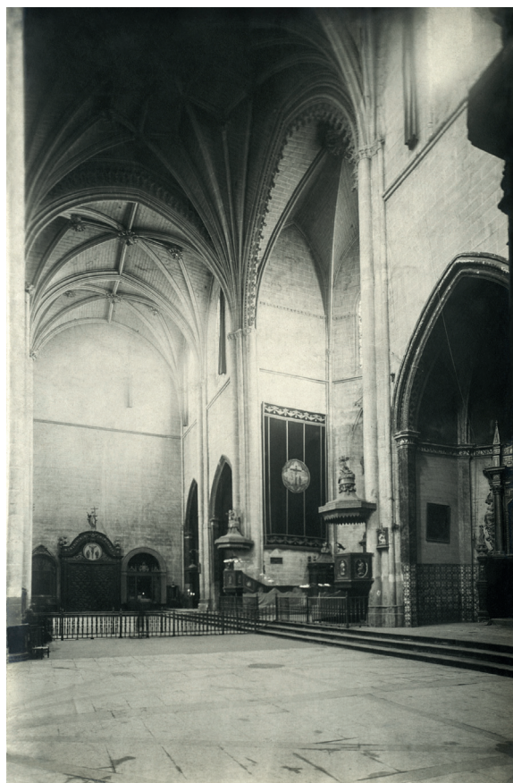
Vista interior de la catedral antes de la intervención que sufrió entre 1968 y 1972, con los arrimaderos de azulejo en su tamaño original. (Fototeca de la Diputación Provincial de Huesca. Colección Roisin. Institut d'Estudis Fotogràfics de Catalunya)
