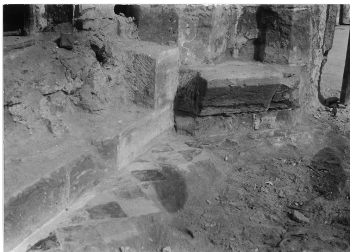
Vista de parte de la azulejería original conservada bajo el pavimento de la catedral durante las obras realizadas en 1969. (Archivo fotográfico del Museo Diocesano de Huesca. Foto: Tricas)
