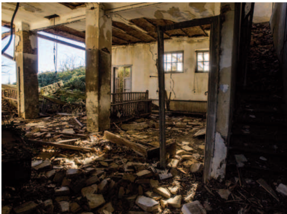
Interior arruinado de uno de los edificios auxiliares. (Foto: Javier de la Fuente Cobos)
