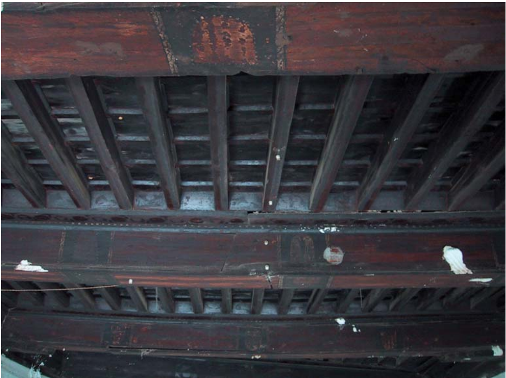
Estado en que fue descubierto el alfarje. (Fundación Ibercaja)
