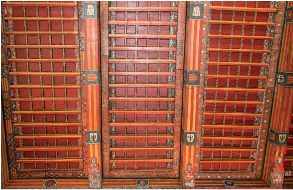
Vista del alfarje en la que se distinguen, en jácenas y aliceres, los cuatro escudos que lo decoran: el de los reyes de Aragón, el de la reina Constanza y los escudos de los Azlor y los Tovía. (Foto: José Antonio Tolosa, www.aragonmudejar.com )
