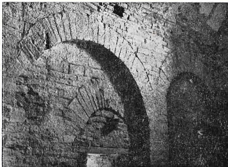
Detalle de la articulación del muro sur y de la puerta tabicada
