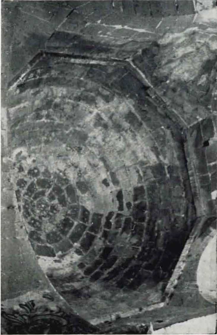
4.— Interior del santuario: cúpula de base octogonal sobre trompas
