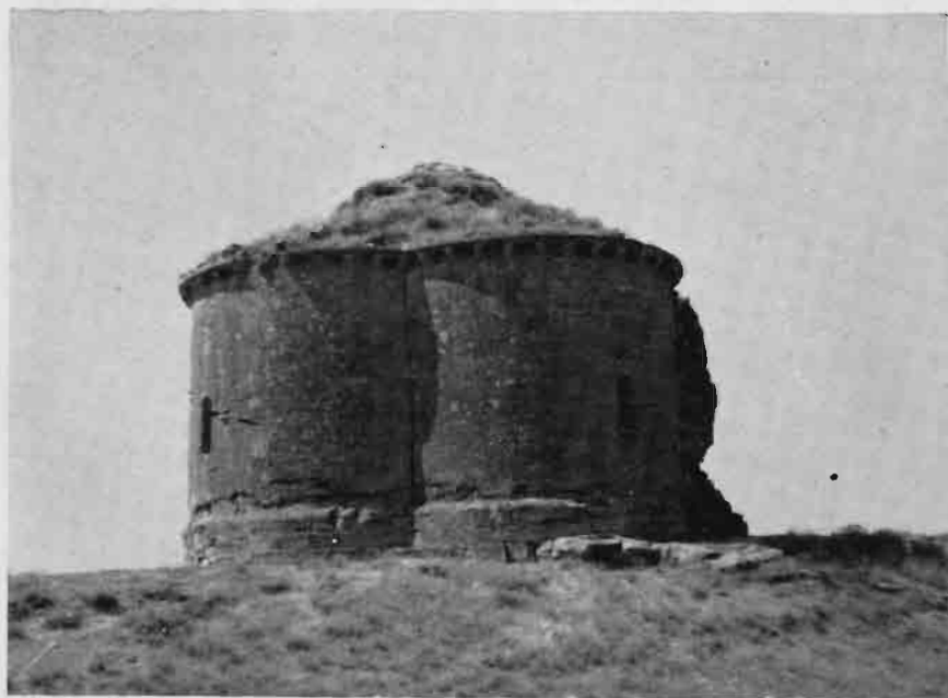
6 — Fachada norte: obsérvese el resto del muro que cubría la nave
