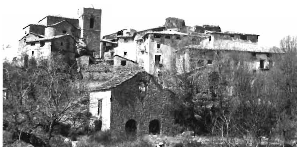
Clamosa. Vista general desde el sur.
