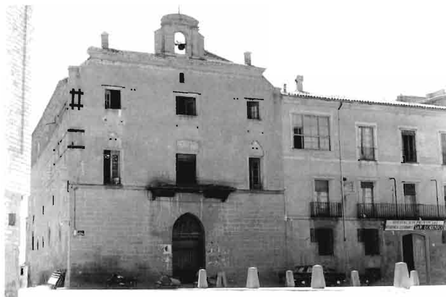
Iglesia del hospital poco antes de su demolición.
