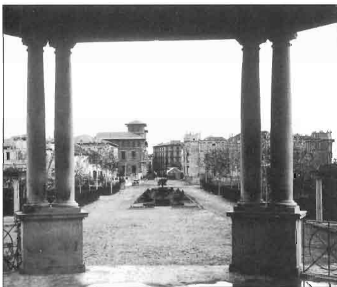
Foto 3. Vista desde el quiosco del parque, hacia 1930-1935. Al fondo, a la derecha, el edificio del Círculo Oscense con el espacio destinado a jardín vallado.
