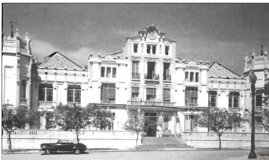
Foto 11. Circolo Oscense (Huesca), proyectado en 1901 por el arquitecto Ildefonso Bonells. Postal editada con motivo de su centenario.
