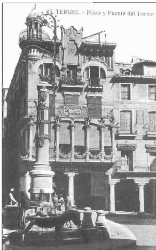
Foto 12. Casa conocida como Tejidos El Torico (Teruel), finalizada en 1912 y realizada por el arquitecto Pablo Monguió. Imagen retrospectiva.
