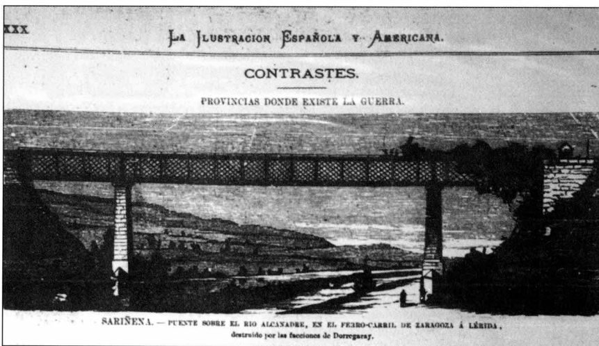
(Foto 18). Vista del puente sobre el río Alcanadre, en el ferrocarril de Zaragoza a Lérida, destruido por las facciones de Dorregaray. Xilografía publicada en 1875 en La Ilustración Española y Americana.
