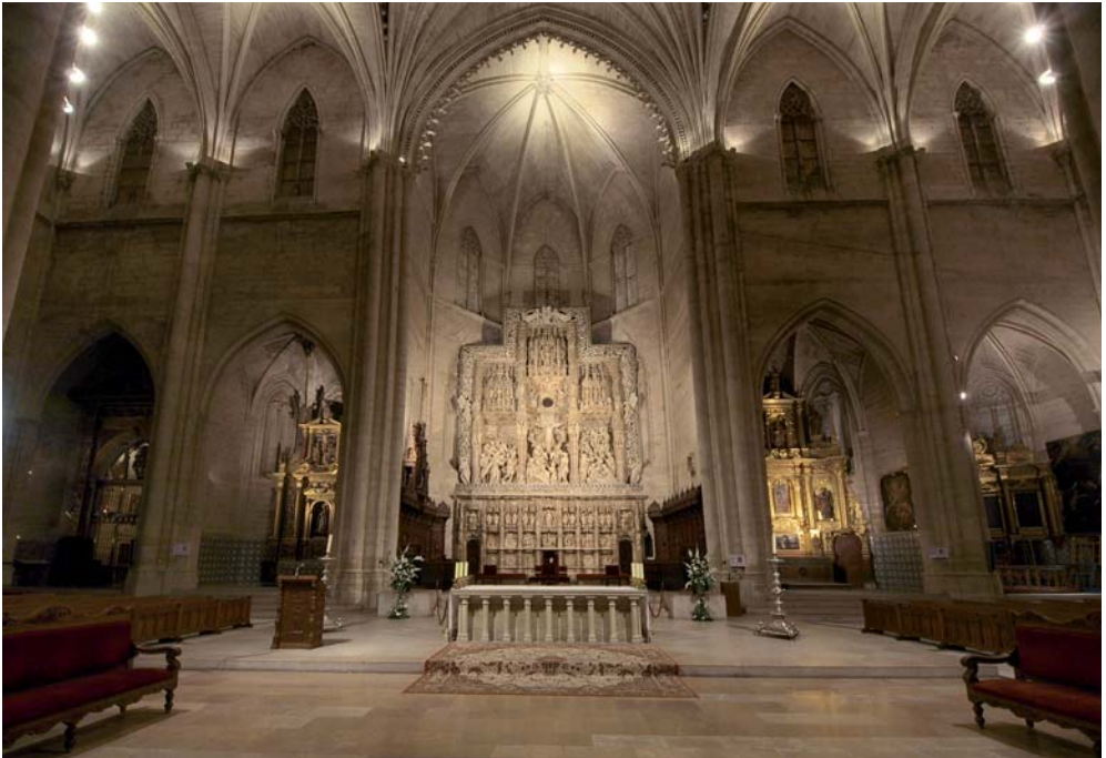
Cabecera de la catedral, con sus cinco ábsides, construida durante el obispado de Jaime Sarroca (1273-1290). Los ventanales superiores y las bóvedas de piedra del crucero son dos siglos posteriores. Sobre los ábsides meridionales se distingue, como un plano inclinado, la altura de la cubierta original. (Foto: Antonio García Omedes)
