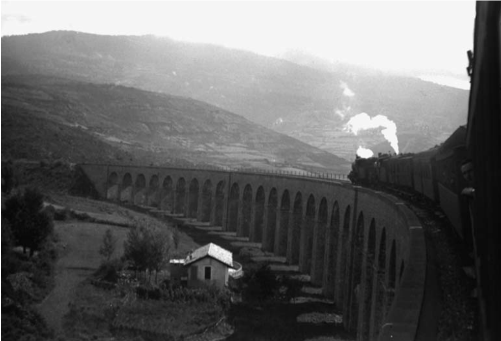
Viaducto de Cénarbe (1943).
