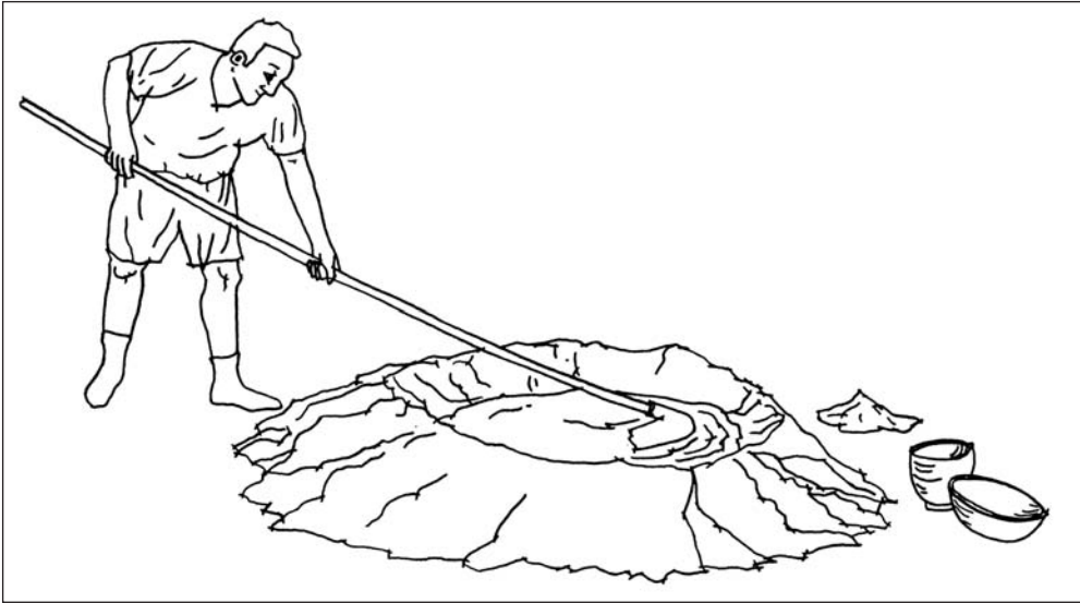
Preparación del mortero de cal a pie de obra. (Dibujo: Jorge Arruga Sahún)
