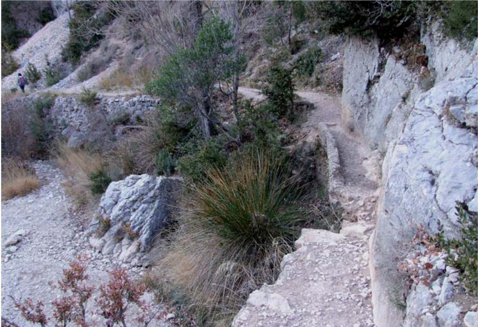
**Fig. 21.** La acequia entre los huertos de Lafarga y Manuel. Se aprecia el estado de la canaleta de obra y lo colmatado de todo el trayecto, hoy convertido en camino. (Fecha: 16/12/2007)
