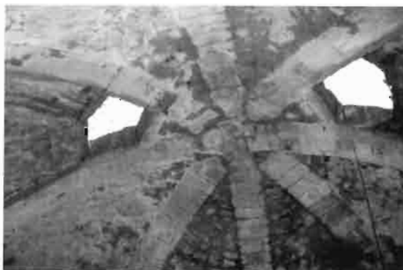
Foto 4. Bóveda del pozo «Campoluengo I».
